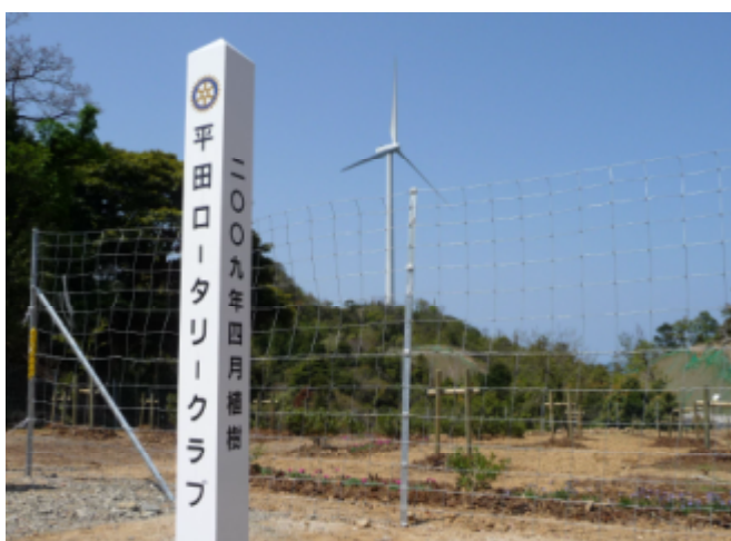
北山山系に棲む鹿の侵入対策として金網フェンスで囲む
